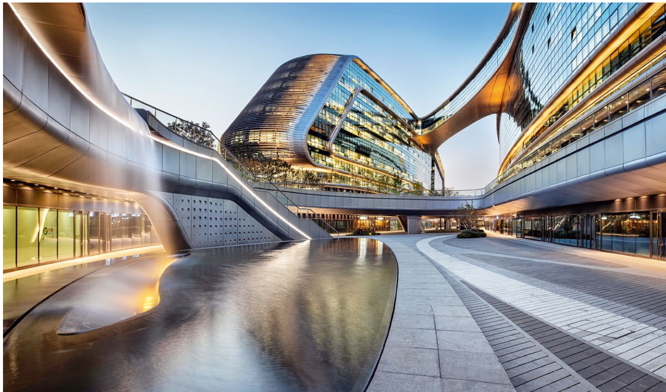
Feng-Shui in moderner Architektur lässt durch Löcher in den Gebäuden das Qi fließen. So in Shanghai beim Sky SOHO (Bild links) und dem World Financial Center (Bild auf der rechten Seite), wegen der charakteristischen Form auch »Flaschenöffner« genannt.
